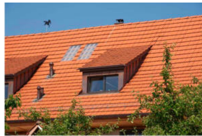
Rechtes Bild: Ungenügend gestaltetes und in die Dachfläche eingebundenes vertikales Lichtband
