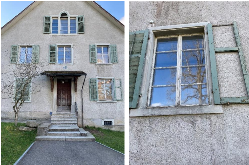
Abbildung 1: Fassadeansicht und defekte Fensterläden
