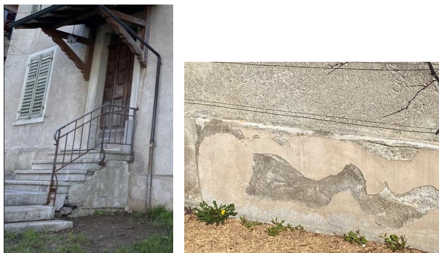
Abbildung 2: Abplatzungen und Risse
