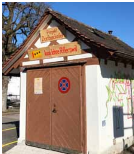
Im ehemaligen «Spritzenhäuschen» wird der Ofen eingebaut.
